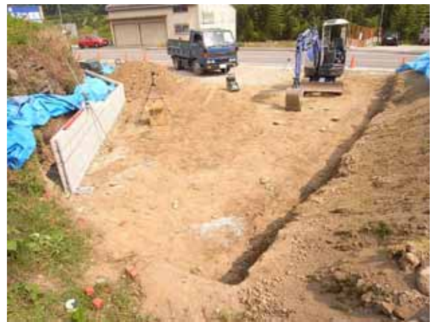
06 調査区(よう壁予定地)掘削前(北西から)
