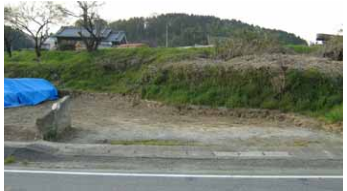
04 工事・調査前
