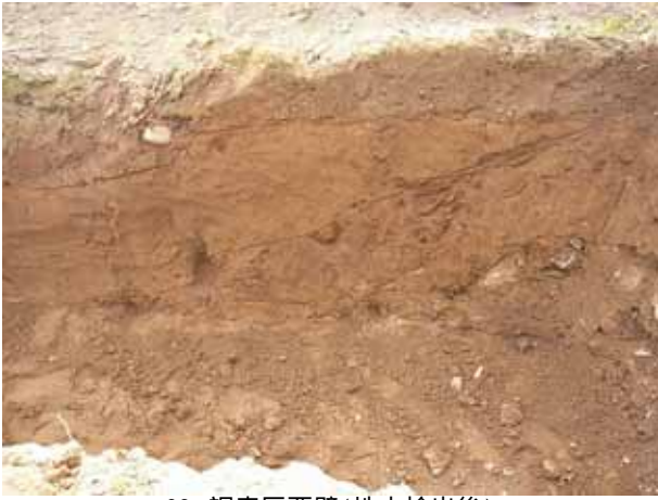
09 調査区西壁(地山検出後)
