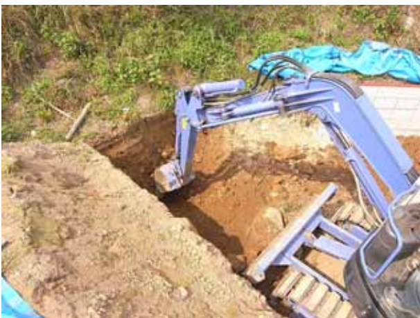
07 調査区掘削中
