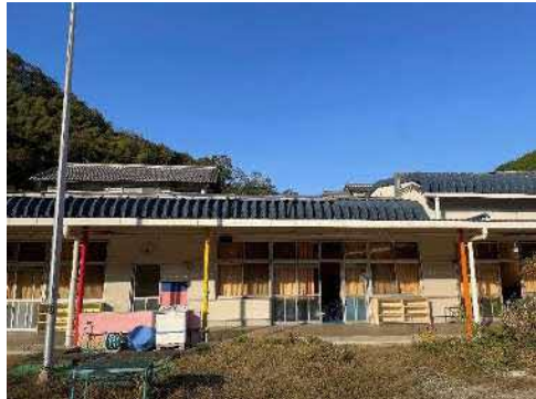
屋根 (太陽光パネル)
