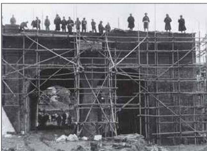
▲明治45年(1912年)・薬水駅のめがね橋建設工事の様子
